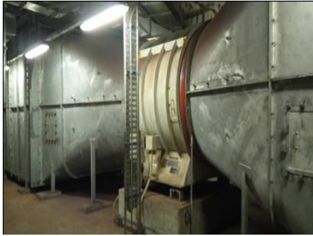
ภาพที่ 2.2-4 ห้องพัดลมระบายอากาศ ใต้ชั้นชานชาลา (UPEF Room)
