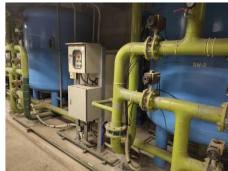
ภาพที่ 2.2-13 เครื่องมือและอุปกรณ์ที่ใช้ในการปรับค่า pH ของน้ำทิ้งจาก Softener
