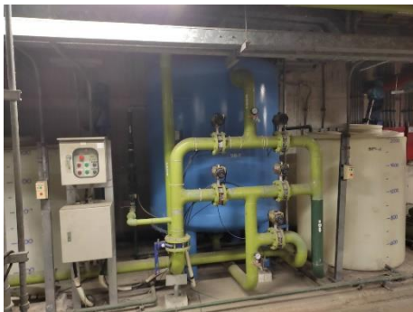
ภาพที่ 2.2-13 เครื่องมือและอุปกรณ์ที่ใช้ในการปรับค่า pH ของน้ำทิ้งจาก Softener
